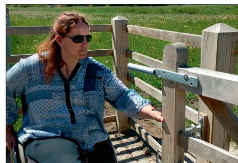
Grinden låses upp från "position 1" till "position 2". Grinden är självstängande och kan därmed aldrig vara halvöppen.
