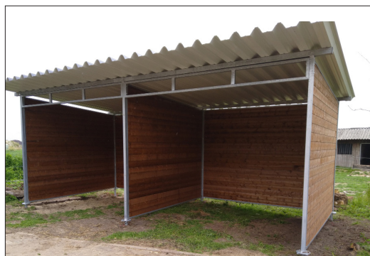
Skiljevägg monterad i Vindskydd
