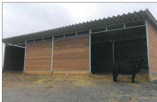
Frontväggar monterad i Vindskydd
