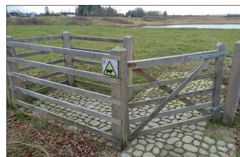
Här är grinden i "position 2". I detta läge hålls grinden fast med en enda grindklinka.
