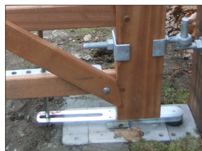
Perfakta för portautomatik. Här visade med nedgjutningsmotor.
